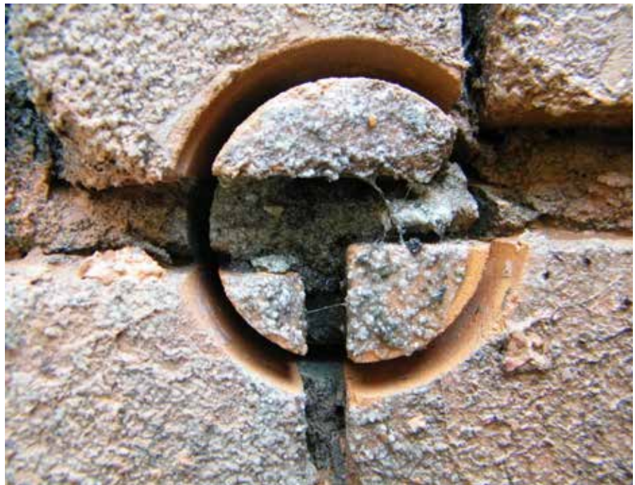
Het sulfaatgehalte in een boorkern uit het metselwerk bepaalt of de ondergrond geschikt is voor het aanbrengen van een verklevend renovatieproduct.
