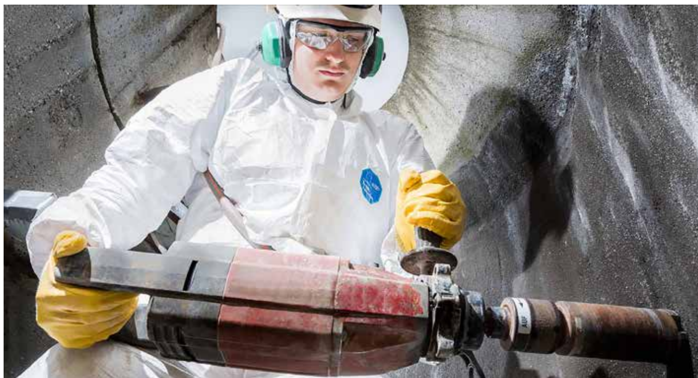
Een boorkernonderzoek geeft onmisbare informatie voor de keuze van de juiste putrenovatie. (foto: www.eventfotograf.in)
