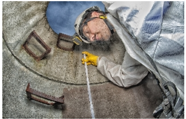
Onderzoek bij putrenovatie
