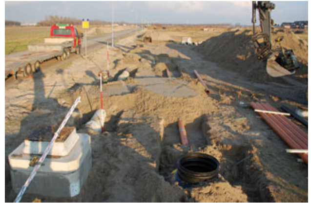
Werken aan de constructie van de testopstelling
