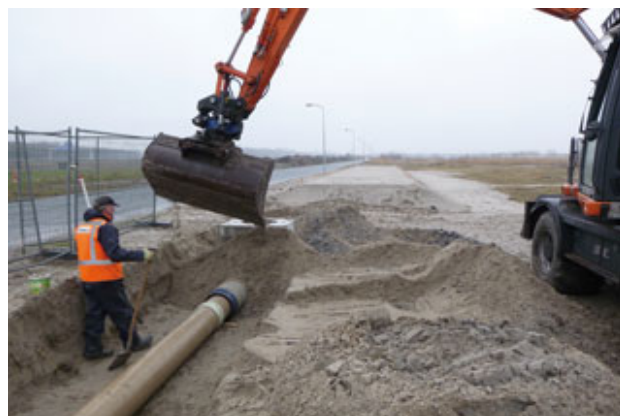
Inbouw van de leidingen in de testopstelling in januari 2019
